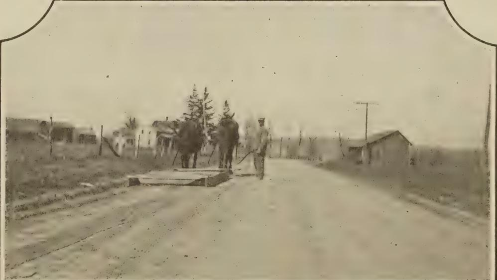
SECTION OF WISCONSIN STATE TRUNK HIGHWAY WEST OF BARABOO. HEAVY CLAY SOIL, RATHER POORLY DRAINED, AND CARRIES RATHER HEAVY TRAFFIC FOR AN EARTH ROAD. TOP VIEW TAKEN AT 9 A. M. FOLLOWING HEAVY RAIN. PATROLMAN HAD MADE A TRIP ONE WAY ON THE CENTER OF THE ROAD WITH A ROAD PLANER. IN CENTER - 15 MINUTES LATER, FOLLOWING PATROLMAN'S RETURN TRIP. BOTTOM - AN HOUR LATER AFTER PATROLMAN HAD COMPLETED SECOND ROUND TRIP WITH PLANER.
